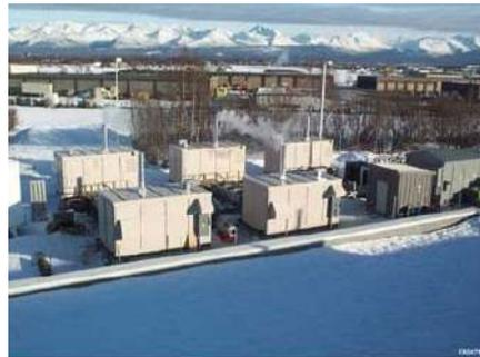
**그림 5.** 분산전원용 연료전지 시스템 실증실험.
